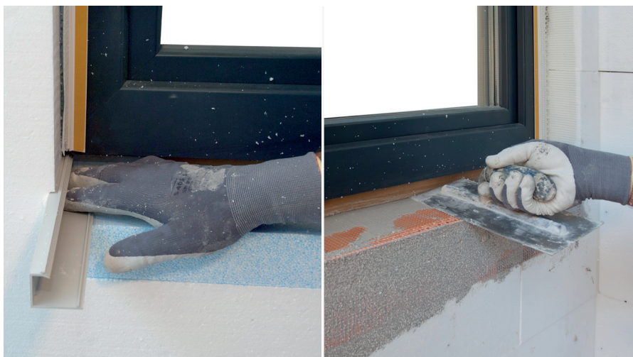
RÖFIX SOL-PAD подprozоречна лайсна за прозорец се лепи с RÖFIX MS POLYMER след което, подprozоречния перваз се шпаклова с RÖFIX OPTIFLEX® 1K или 2K.
