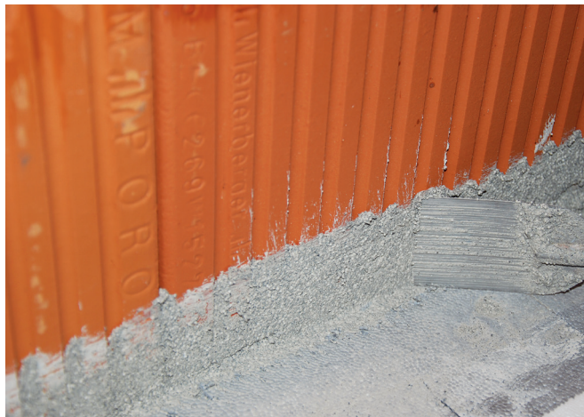
Фугата се затваря плътно с лепило (минимум на всяки трети ред)
