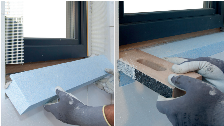
RÖFIX SOL-PAD Base се залепва, след което се изрязва (изшлайфа) канал за монтаж на профила.
