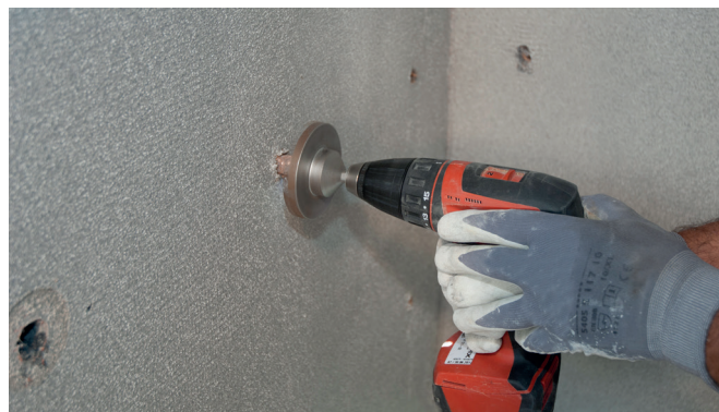
8 mm отвор за дюбел се разширява с 18 mm фреза за мазилка
