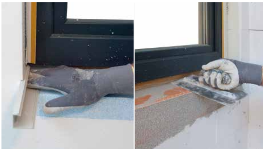
Të ngjitet listela RÖFIX SOL-PAD e shtratit të parvazit me RÖFIX MS POLYMER, pastaj të stukohet në mënyrë izoluese zona e marrjes së pllakës së parvazit me RÖFIX OPTIFLEX® 1K ose 2K.
