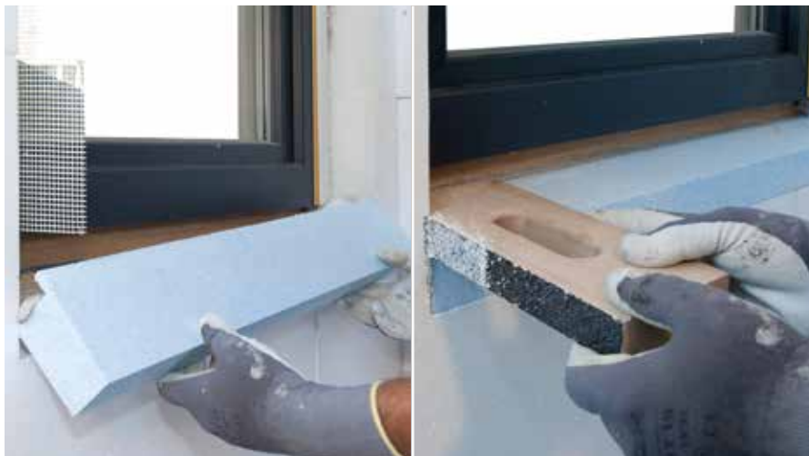
Të ngjitet RÖFIX SOL-PAD Base dhe të hapet një kanal për pranimin e profilit.
