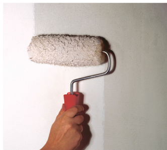
Gruntavimas tinko gruntu.
