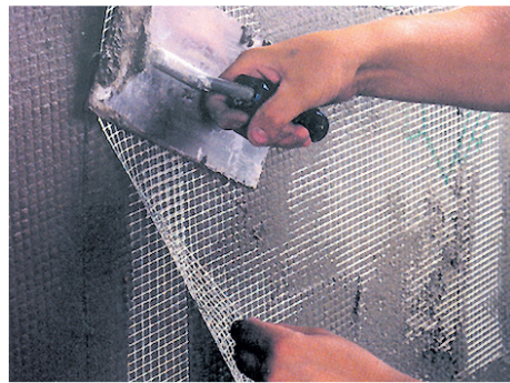
Viena ant kitos juostos užleidžiamos ne mažiau kaip 10 cm.
