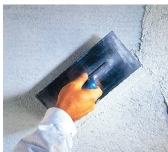
Gruntavimas tinko gruntu.
