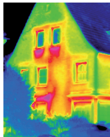
Една термография показва топлинните загуби през фасадата
