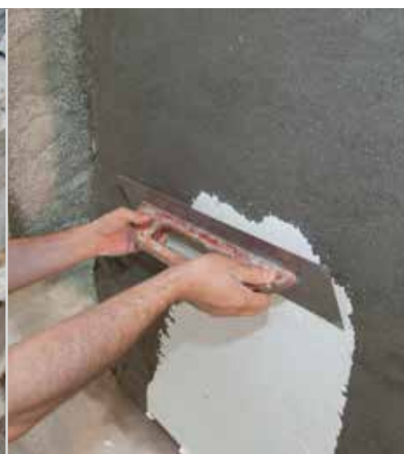
RÖFIX 340/341 бяла/сива издърпване
