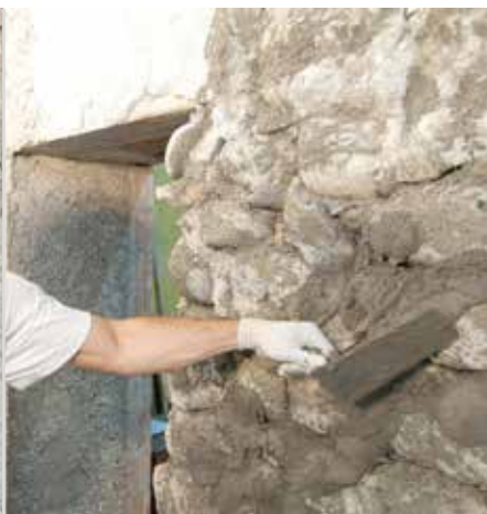
Попълване/Нанасяне с RÖFIX 648 Пореста хастарна мазилка
