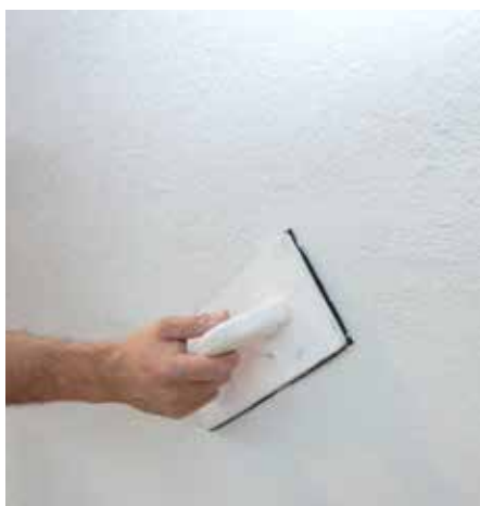
Структуриране с RÖFIX Renopor® Специална лепилно-шпакловъчна смес
