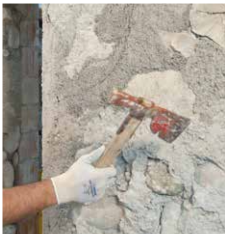
Отстраняване на старата мазилка
