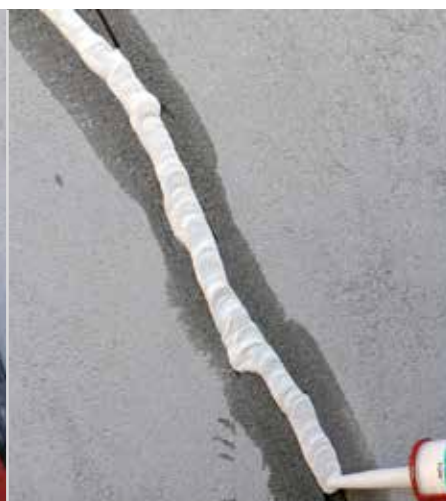
Запълване на фугите с акрилен кит
