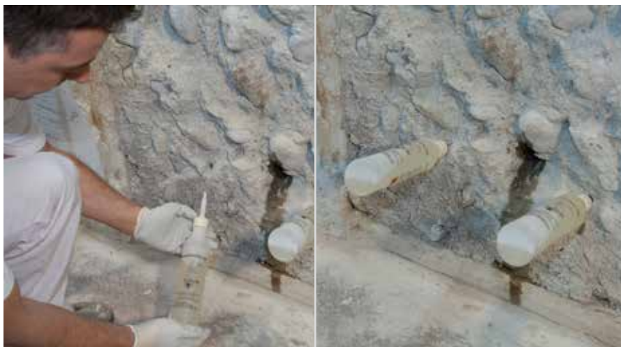
RÖFIX Cavastop Преградата за капиларна вода се слага на 10–15 cm над нивото на пода
