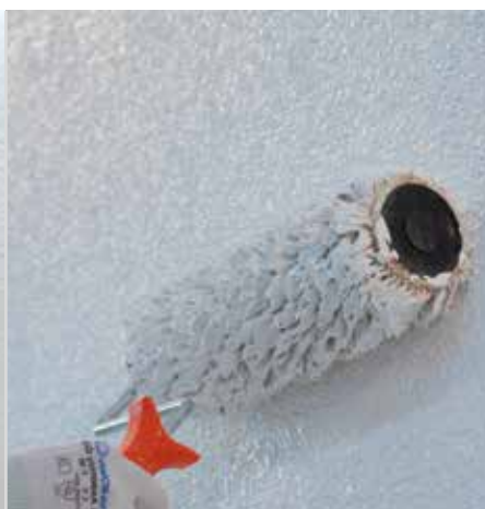
Покриване с паропропускливи бои
