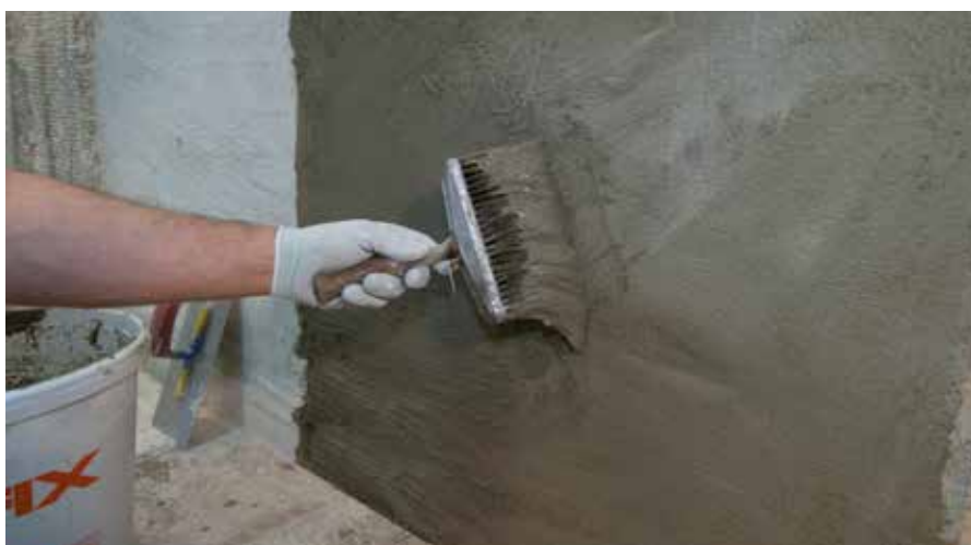
RÖFIX 636 Уплътнителен шлам с max. 3 mm дебелина на пласта се полага върху RÖFIX 635
