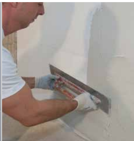
Армиране с RÖFIX Renopor® Специална лепилно-шпакловъчна смес
