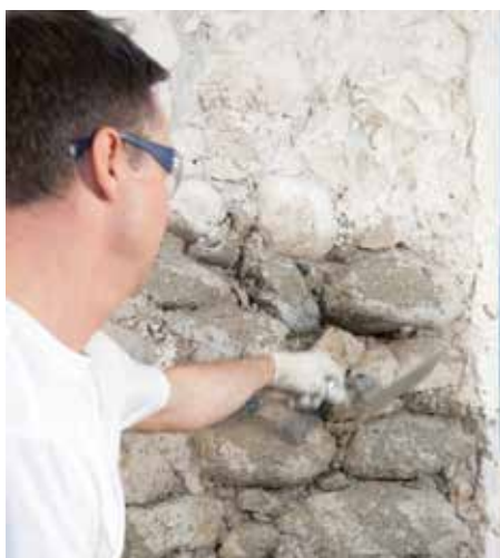
Нанасяне на RÖFIX 671 Санирац предварителен шприц, покриващ 60 % от повърхността
