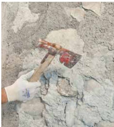
Отстраняване на старата мазилка
