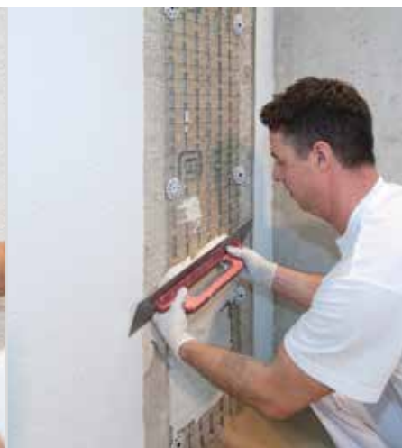
Обработка на пукнатините (RÖFIX Stucanet) основа за мазилка
