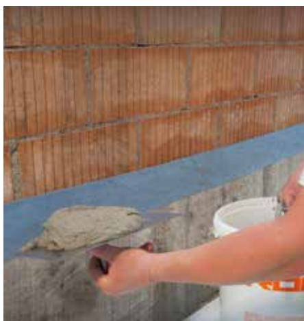
RÖFIX Лента за саниране на пукнатини, като защита от образуване на пукнатини
