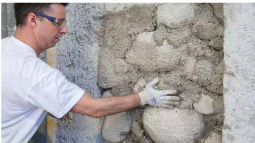
„Запушване“ на отворите
