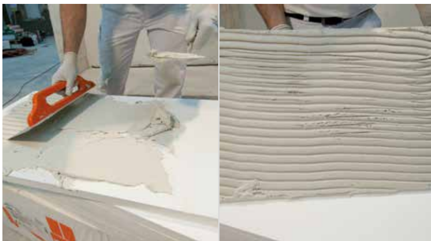
Пълноплътно залепване с RÖFIX Renopor® лепилно-шпакловъчна смес
