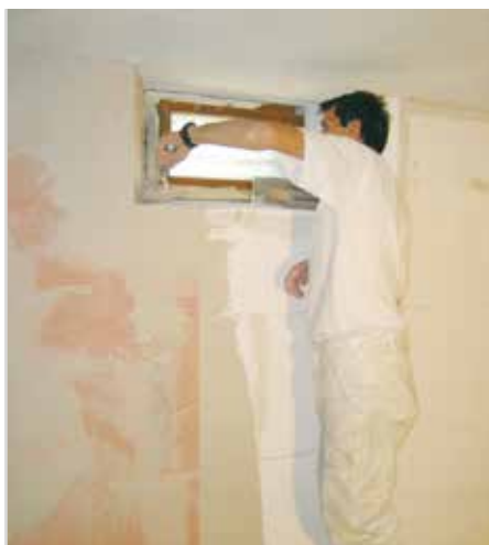
Монтаж с RÖFIX Renopor® Напасващ клин
