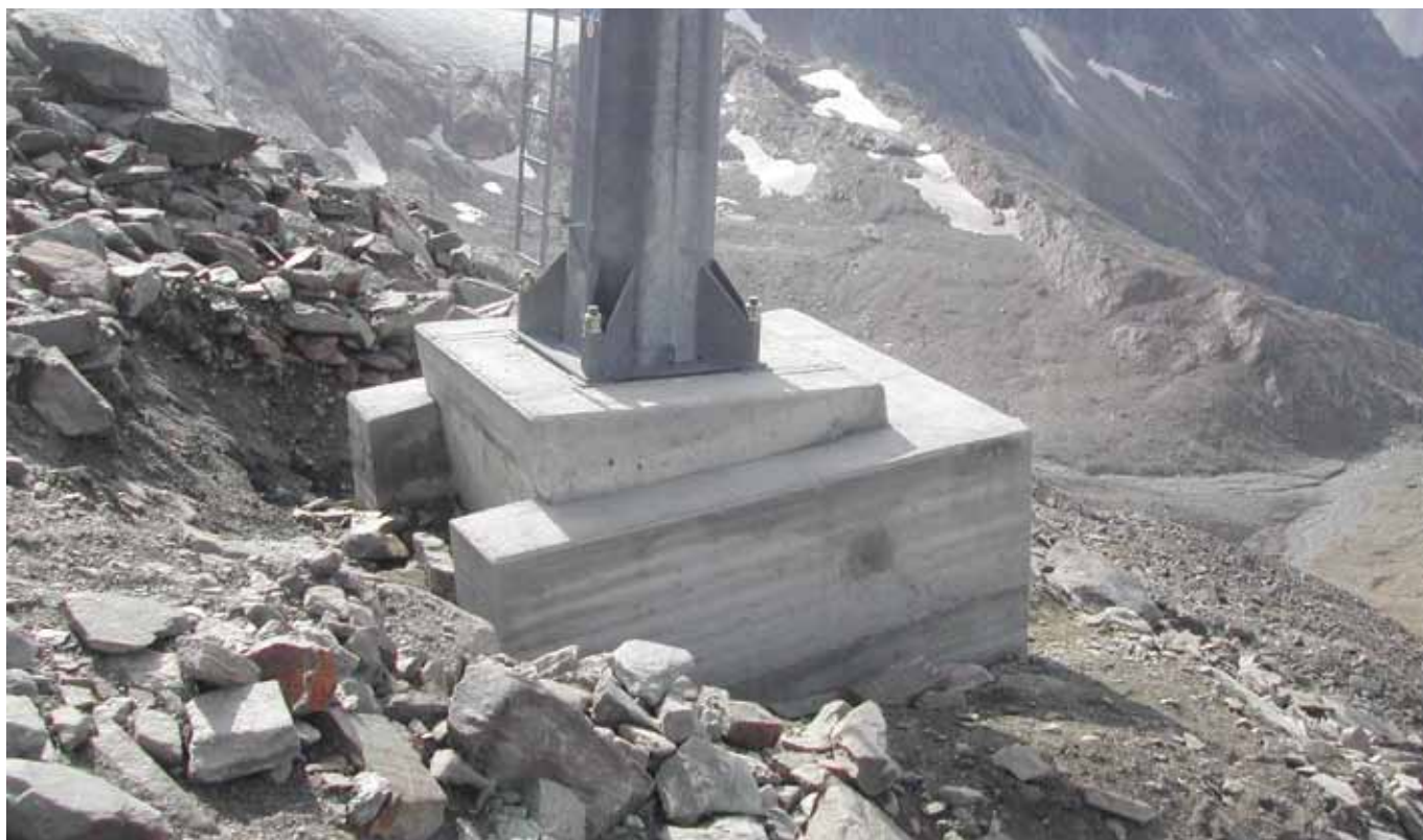
Проект/място: Саниране на опорни стълбове Neustift (АТ) Продуктова група/продукт: Стандартен бетон /Creteo®Standard 990 B30
