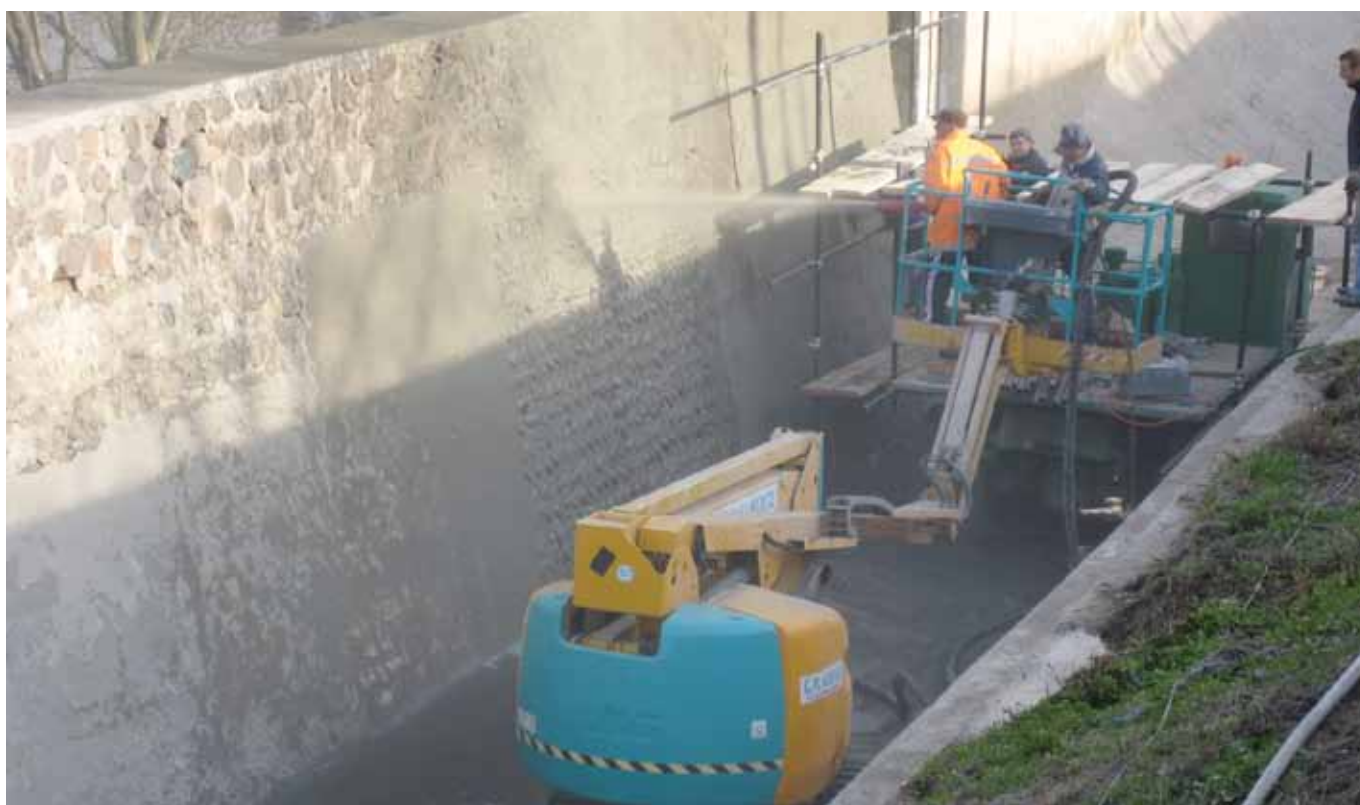
Проект/място: Воден канал Verona (IT) Продуктова група/продукт: Бетон за възстановяване/Creteo®Shot RG4 M HS
