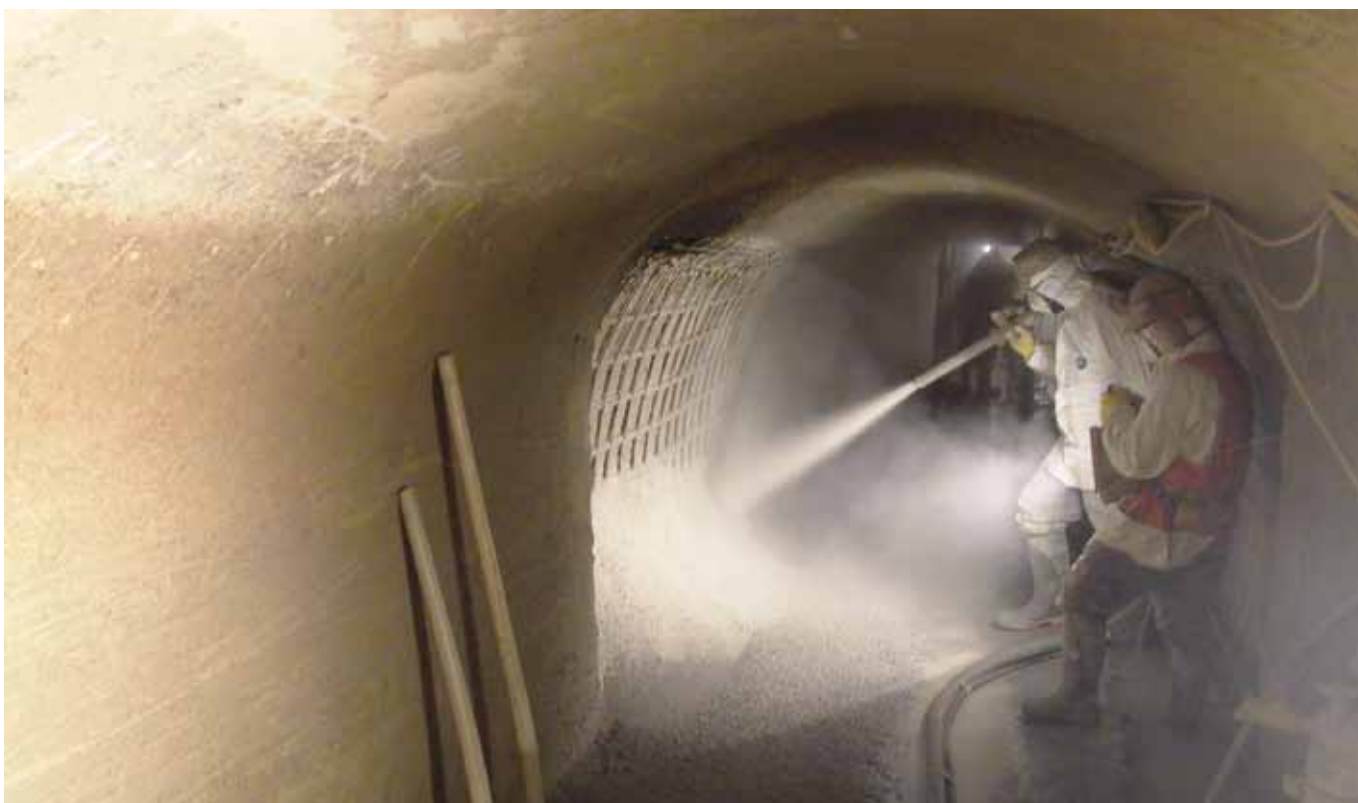
Проект/място: Саниране на напорен тунел Urnäsch (CH) Продуктова група/продукт: Торкретбетон/Creteo®Shot RG8 S
