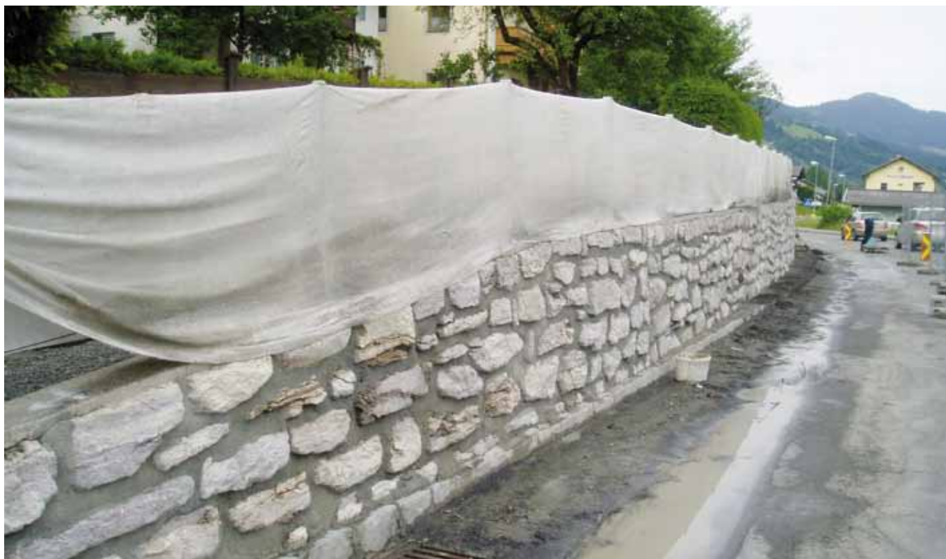
Проект/място: Саниране на фугите на зид от естествени камъни Korfgarten (AT) Продуктова група/продукт: Ландшафтно строителство/Creteo®Gala 996
