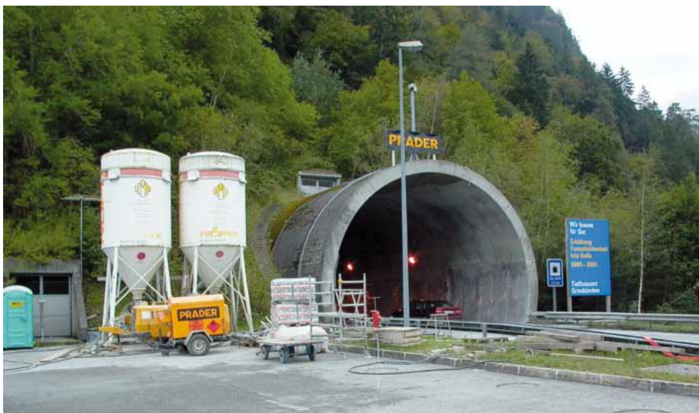
Проект/място: Саниране на тунел Isla Bella (CH) Продуктова група/продукт: Възстановяване на бетон/Creteo®Shot RG 4M, Creteo®Shot RG8 SM
