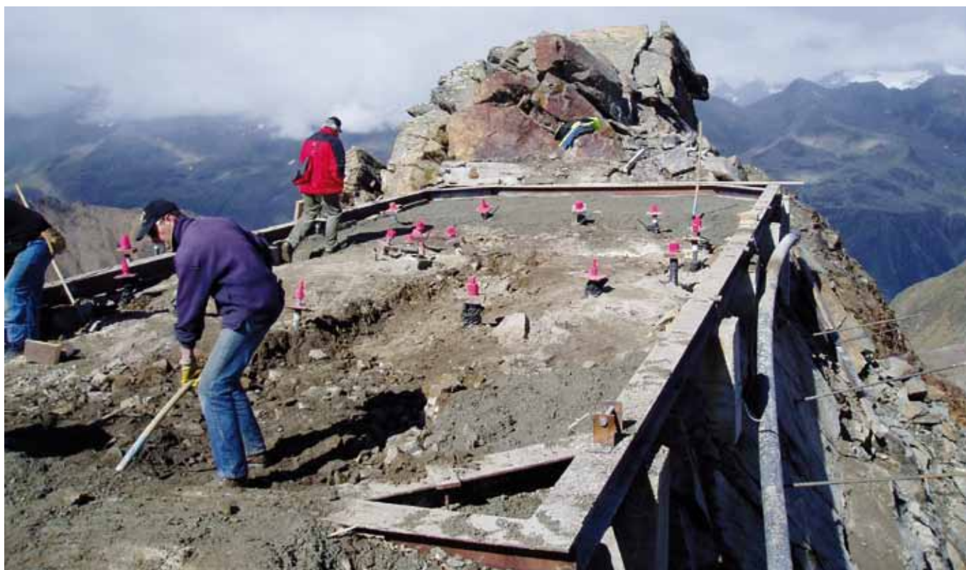
Проект/място: Платформа Obergurgl (АТ) Продуктова група/продукт: Инжекционен бетон/Creteo®Injekt 995
