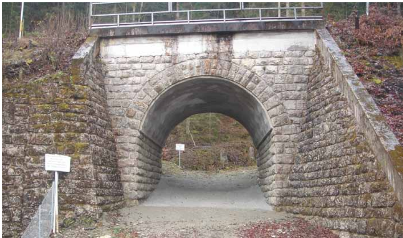
Проект/място: Саниране на железопътен мост Ehrwald (AT) Продуктова група/продукт: Торкретбетон/Creteo®Shot RG8
