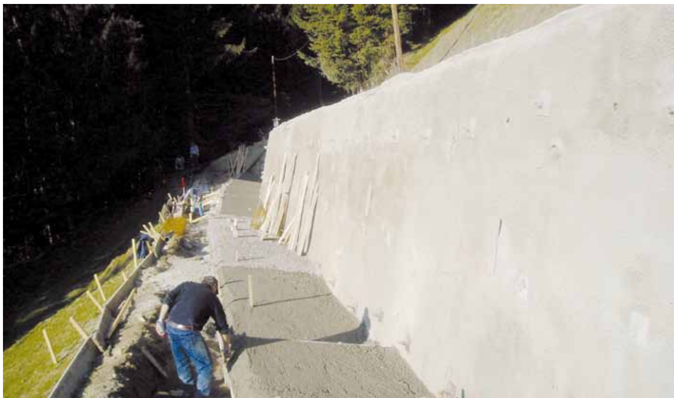
Проект/място: Преграждане на склон Kitzbühel (AT) Продуктова група/продукт: Торкретбетон/Creteo®Shot RG8 S t; инж. разтвор/Creteo®Injekt 995
