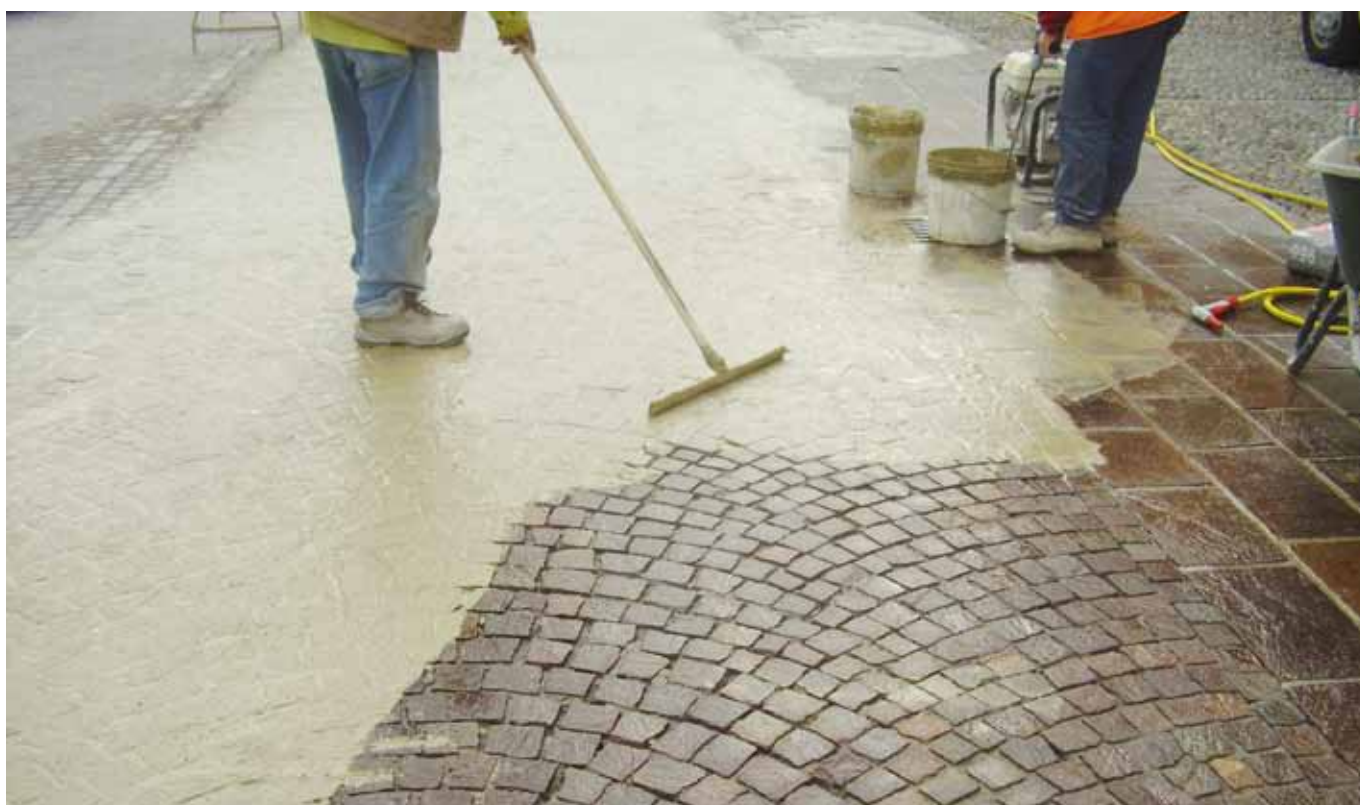
Проект/място: Фугиране на паваж от естествени камъни (AT) Продуктова група/продукт: Специален бетон/Creteo®Special NOK
