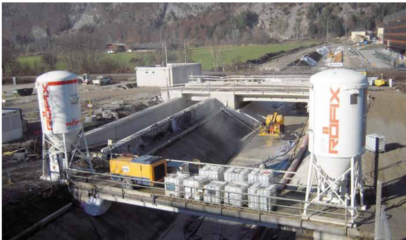
Проект/място: Саниране на канал Jenbach (AT) Продуктова група/продукт: Възстановяване на бетон/Creteo®Shot RG4 M
