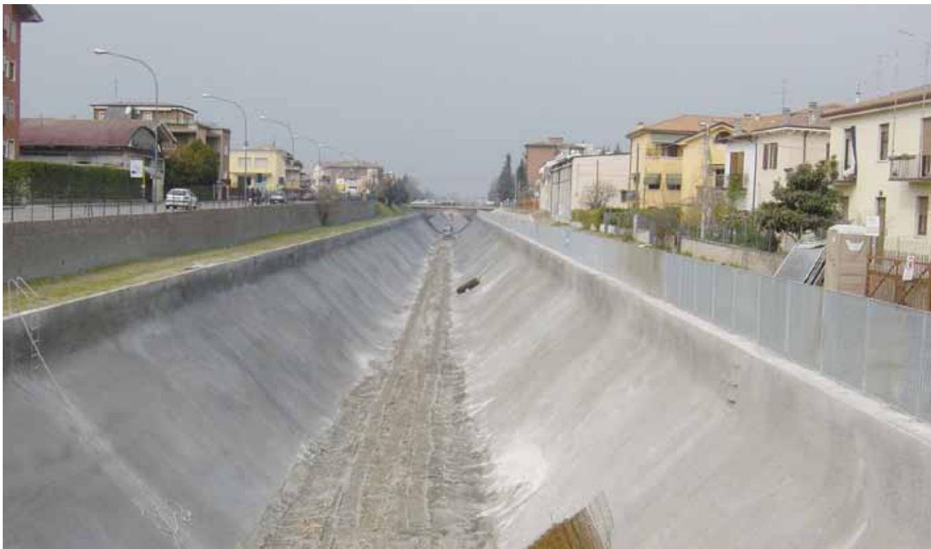
Проект/място: канал за отпадни води Verona (IT) Продуктова група/продукт: възстановяване на бетон/Creteo®Injekt RG4 M
