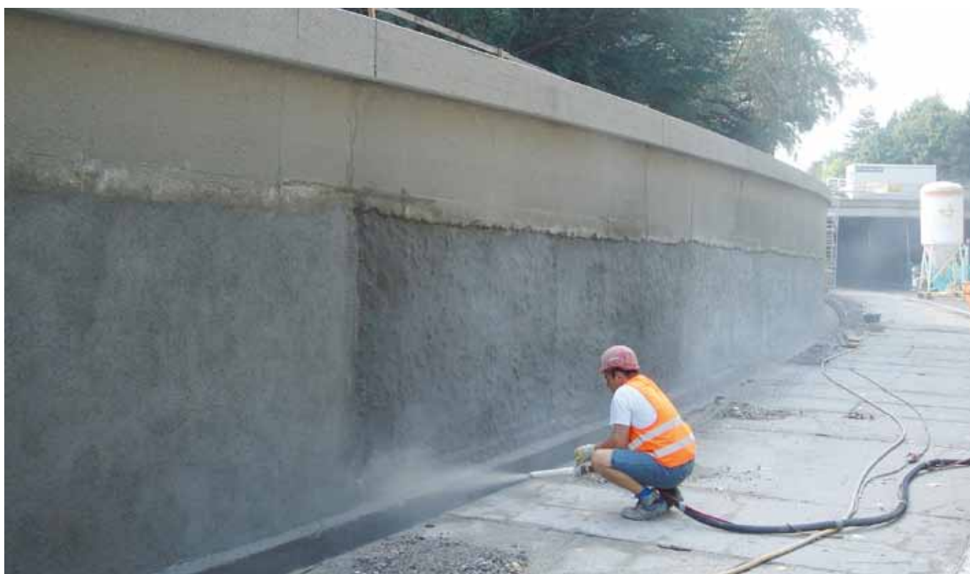
Проект/място: Саниране на тунел -Altmannsdorf Wien (AT) Продуктова група/продукт: Възстановяване на бетон/Creteo®Shot RG 4M
