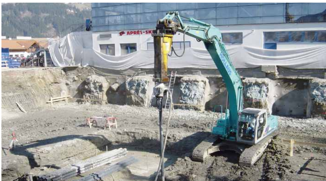
Проект/място: Отливане на крепежна стойка Kaltenbach (AT) Продуктова група/продукт: Инжекционен разтвор/Creteo®Injekt 997
