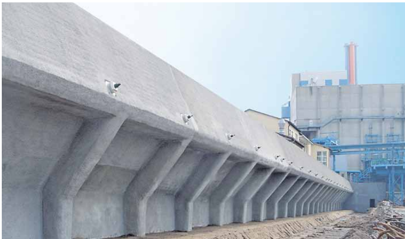
Проект/място: Електроцентрала Schwandorf (DE) Продуктова група/продукт: Торкретбетон/Creteo®Shot RG4, RG8; инжекц. бетон/Creteo®Injekt 995
