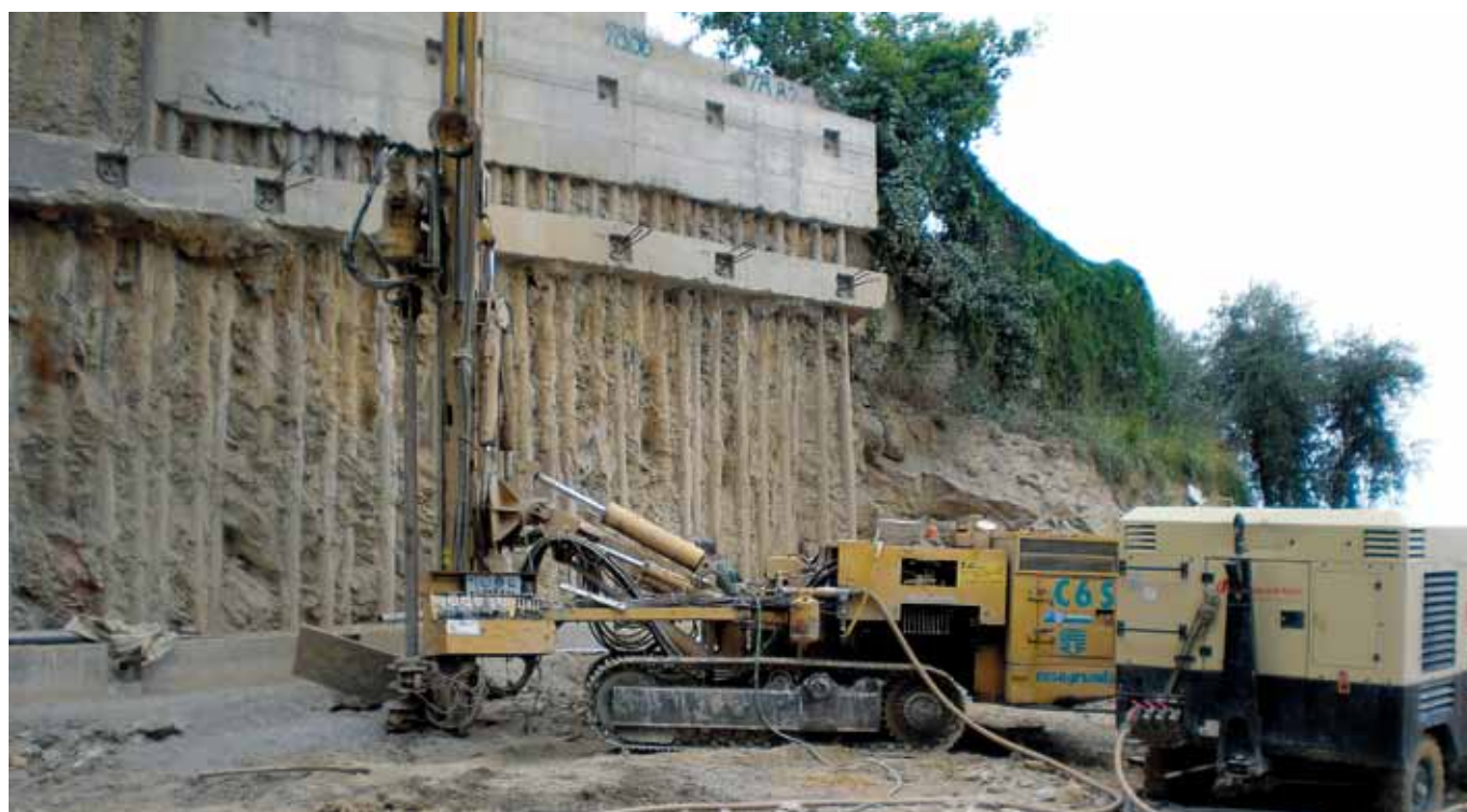
Проект/място: Геотермални сондажи Genua (IT) Продуктова група/продукт: инжекционен разтвор/RÖFIX Thermo-Injekt 100
