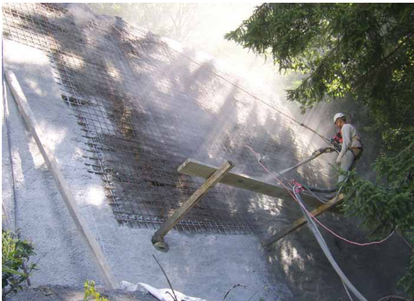
Проект/място: Саниране на подпорна стена Klösterle (AT) Продуктова група/продукт: Торкретбетон/Creteo® Shot RG8 S t
