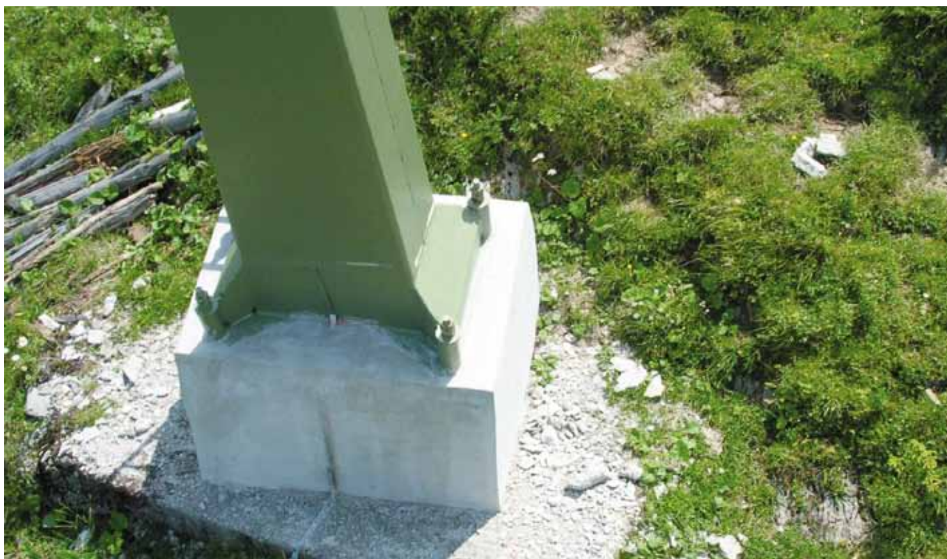
Проект/място: Планинска железница Bizau (AT) Продуктова група/продукт: Възстановяване на бетон/Creteo®Repair CC 100; Creteo®Repair CC 130
